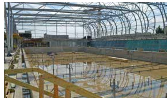
Az új városi uszoda építése
